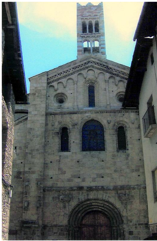
Catedral de Santa María de Urgel (provincia de Lérida) – Fachada principal y campanario
