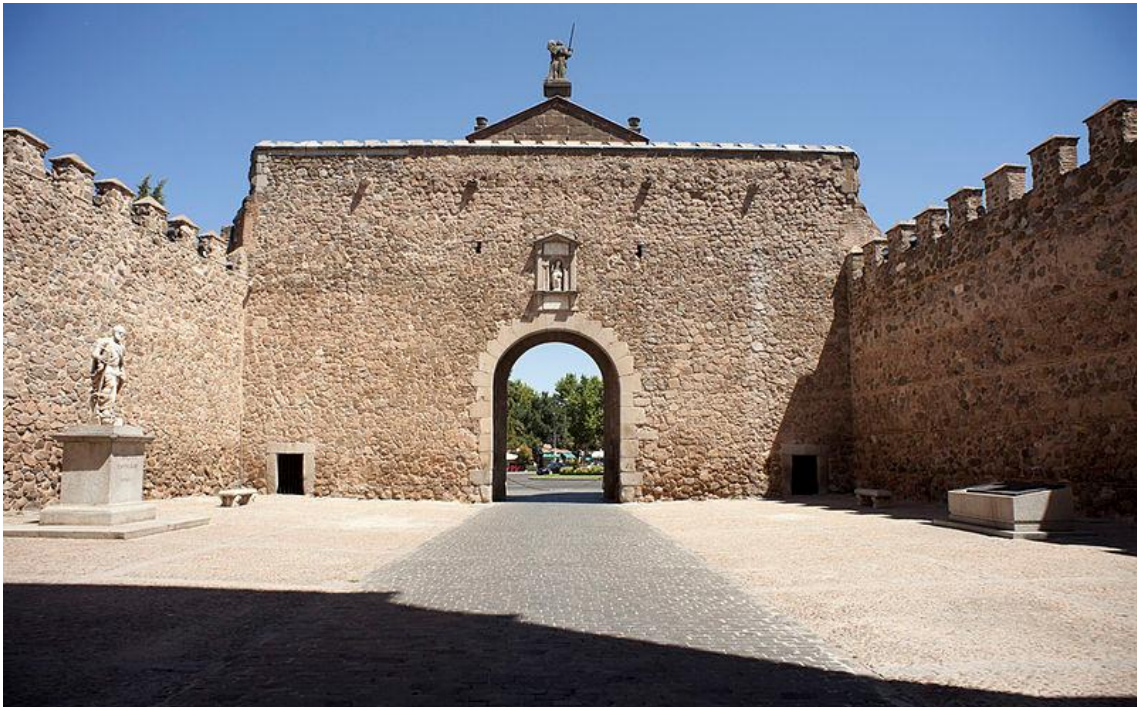
Puerta Nueva de Bisagra (Toledo) – patio entre ambas fachadas con la estatua de Carlos V a la izquierda.
